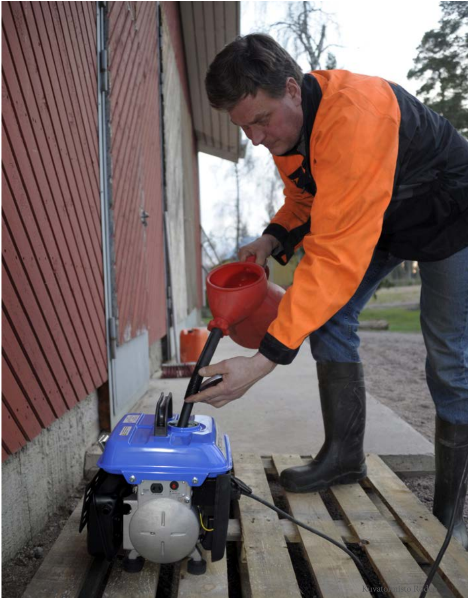
Aggregaatti kierrätti asuintalon lämpöpumpun vesiä jouluna 2011. Perhe oli ilman sähköä talvimyrskyistä johtuvan sähkökatkon takia.
